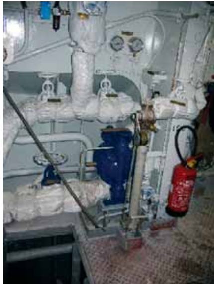
Ogrzewacz paliwa do kotła – rzeczywista lokalizacja na statku
